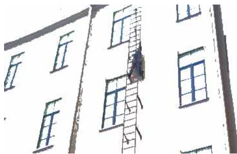
Рисунок 42. Спуск по стационарной настенной пожарной лестнице.
